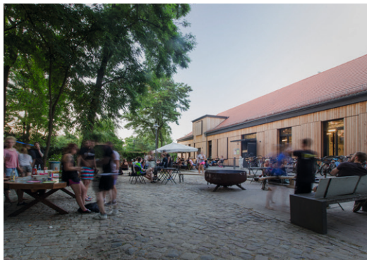
Das sanierte Haus 17 im Jahr 2018.
